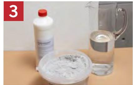
3 Mit dem Rührwerksmischer in sauberes Leitungswasser (ca. 0,9–1,3 l je nach Nuance auf 1 kg Trockenmasse) bzw. bei gegebener Kennzeichnung mit Anmachflüssigkeit einrühren.
